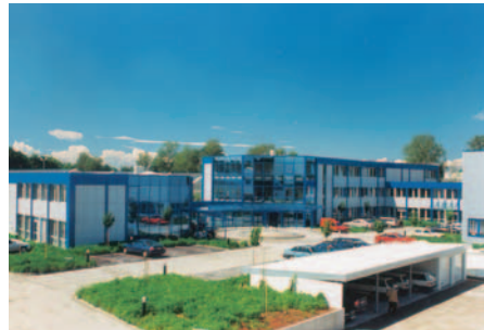
Brandenburg: Seit 1997 produziert die Firma Aqua Rotter GmbH am Standort Ludwigsfelde Wassermanagementsysteme und Sanitär-raumausstattungen
