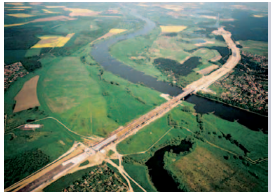
Sachsen-Anhalt: Schnelle Schiffsverbindung zwischen Ost und West durch das neue Wasserstraßenkreuz Magdeburg
